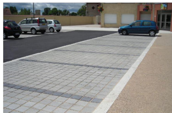
Exemple d'un pavage drainant à joints gravillonnés
