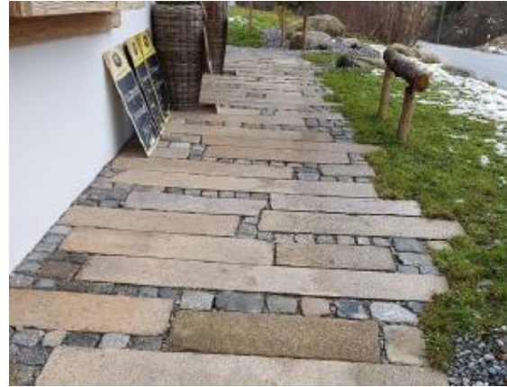
Exemple d'un calepinage mixte dallage/pavage
